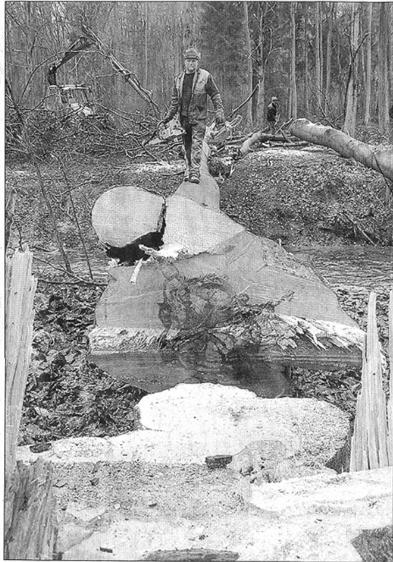
Insgesamt acht große Bäume wurden abgeholzt.
